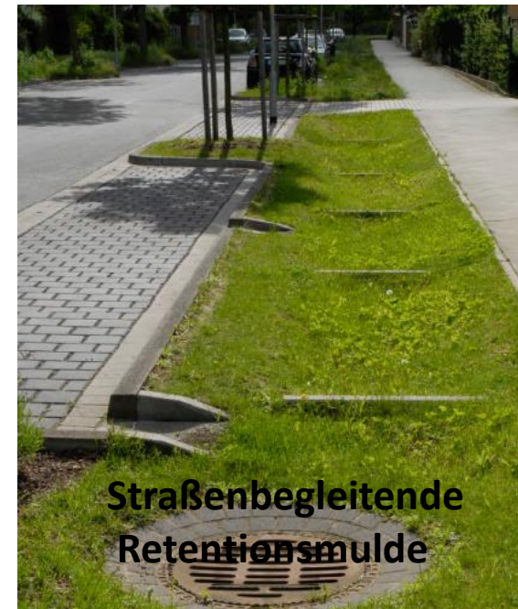
Versickerung über Tiefbeete im Straßenseitenraum
