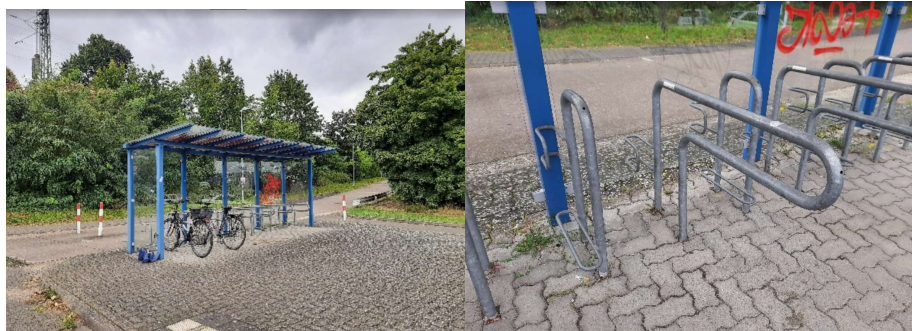
Abbildung 1-31: Anlage am Bahnhof Urmitz-Rheinbrücke
