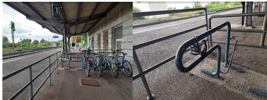
Abbildung 1-32: Anlage am Bahnhof Vallendar
